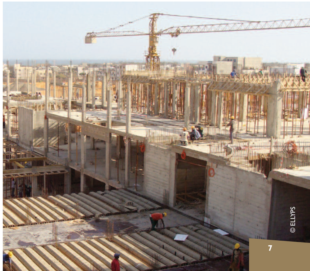
Nouvel hôpital Delal Jamm en cours de construction à Dakar
