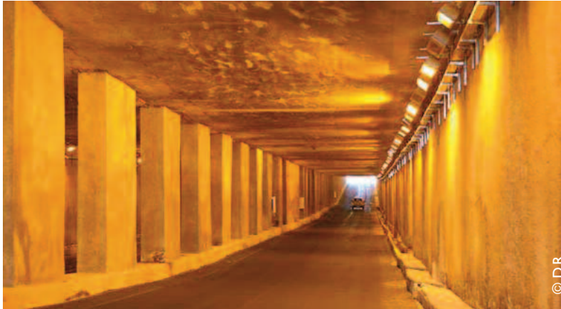
Tunnel sous la Corniche Ouest
